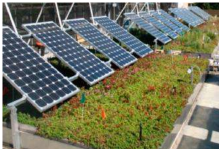
Il.150. Zielony dach z podniesioną strukturą generatorów (źródło zdjęcia wg. przypisu 185 )
