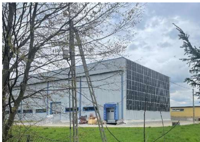
Il.144b. Moduły fotowoltaiczne dodane do fasady obiektu (źródło zdjęcia wg. przypisu 170 )
