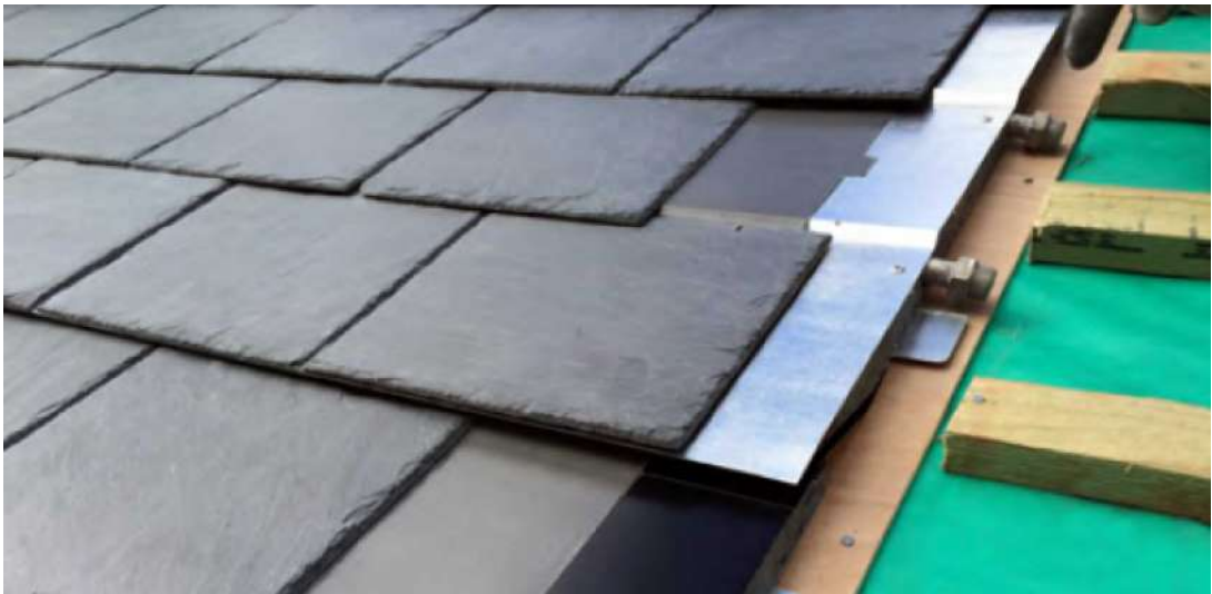
Il.136c. Montaż modułu kolektorowego (źródło zdjęcia: Thermoslate CupaPizzaras)
