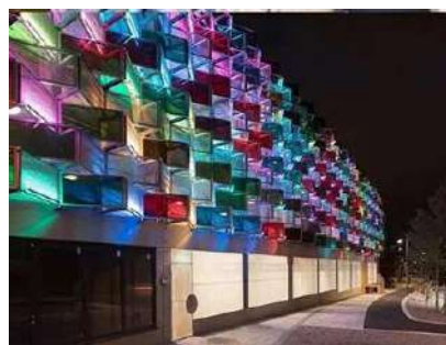
Il.144d. Kolorowe moduły fotowoltaiczne na fasadzie (źródło zdjęcia wg. przypisu 172 )
