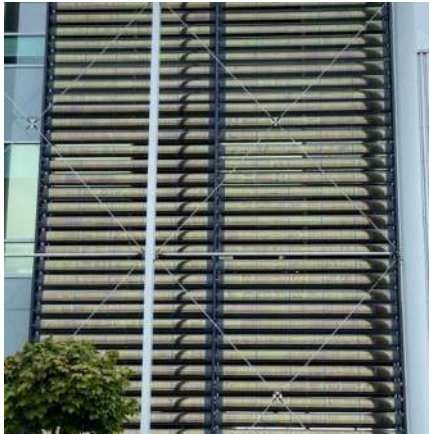
Il.139c. Perowskitowe żaluzje fotowoltaiczne (źródło zdjęcia: PV Magazine)
