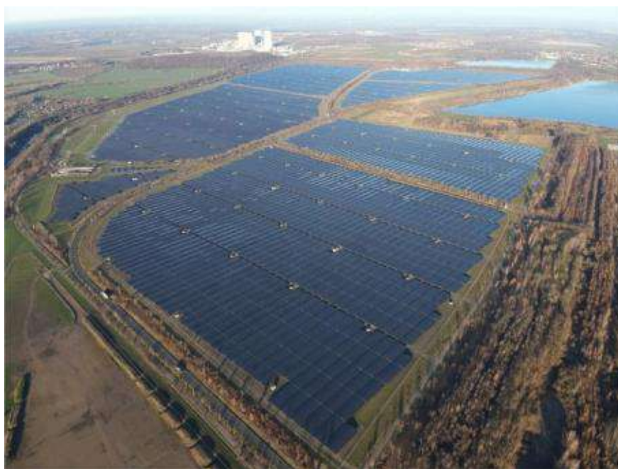
Il. 16. Widok na elektrownię Witznitz II Solar (źródło zdjęcia wg. przypisu 74 )
