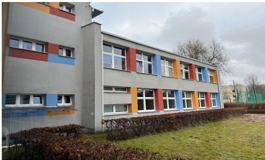
Il. 59. Widok na elewację szkoły. Fot. A. Synowiec.
