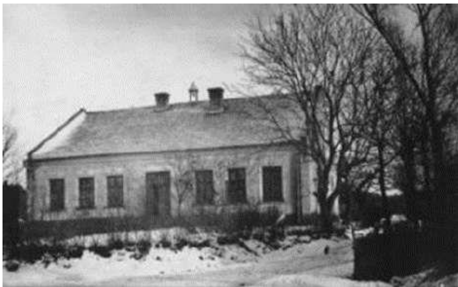
Il. 10. Budynek szkolny w Budziwoju (obecnie Rzeszów) – murowany, dwuklasowy wybudowany w 1896 r. jako trzeci obiekt istniejącej tu od 1847 r. szkoły. Zdjęcie z 1933 r. Źródło: http://zszp7.ayz.pl/index.php/o-nas/historia/zdjecia (dostęp: 24.10.2022).
