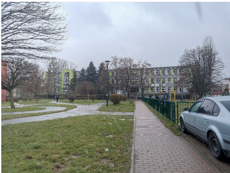
Il. 49. Widok na budynek (elewacja frontowa, strefa wejściowa) liceum od strony wschodniej. Fot. D. Moskal.
