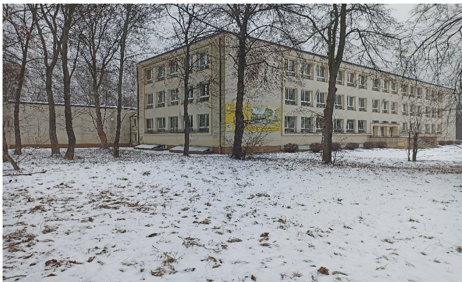
Il. 57. Widok na budynek szkoły oraz zagospodarowanie terenu od strony południowej. Fot. D. Moskal.
