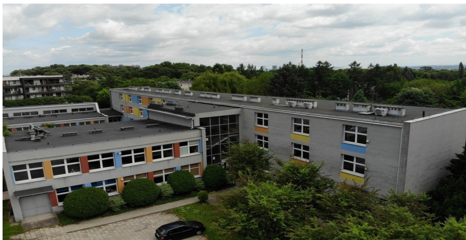
Il. 60. Zdjęcie z dronu na wnętrze urbanistyczne placówki szkolnej. Źródło: strona internetowa Zespołu Szkół Inżynierii Środowiska i Melioracji w Krakowie, https://zsisim.pl/strona-glowna-2/galeria-2/galeria-zdjecia-z-drona/ .
