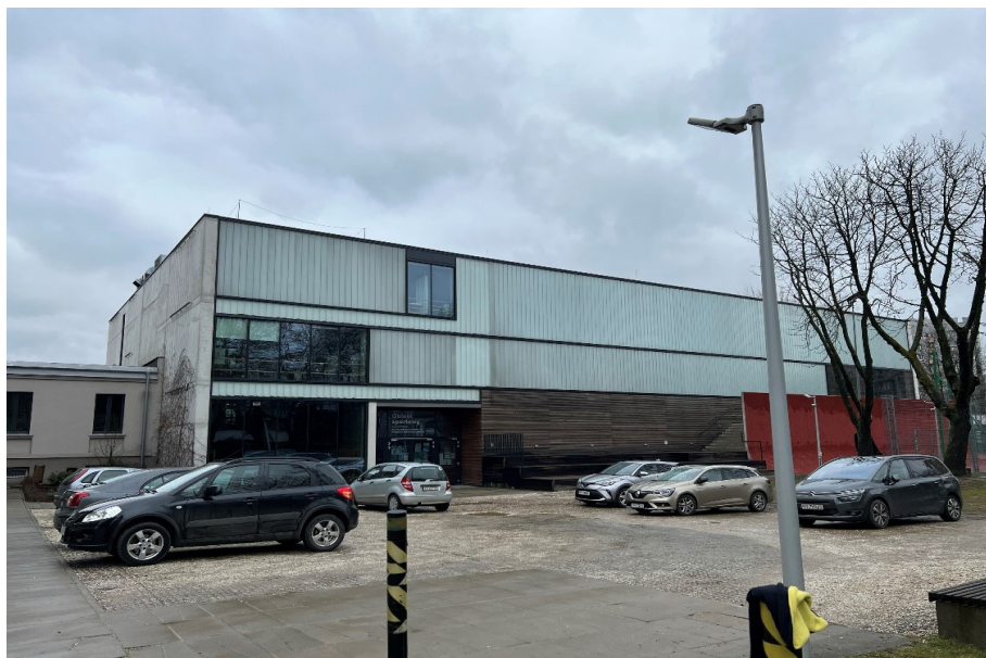
Il. 47. Widok na halę sportową. Fot. A. Synowiec.
