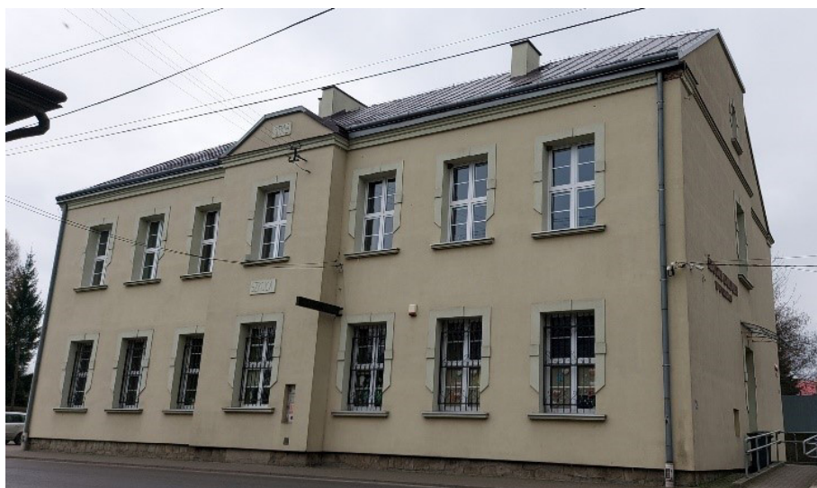
Il. 14. Szkoła w Ryglicach wybudowana w 1912 r. Fot. M. Wdowiarz-Bilska, 2023.
