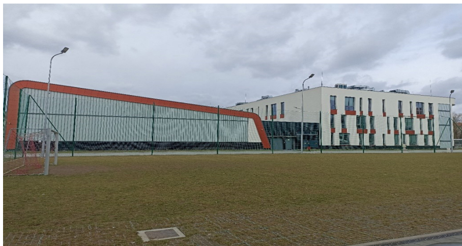
Il. 34. Sala gimnastyczna połączona z główną częścią budynku. Fot. D. Moskal.
