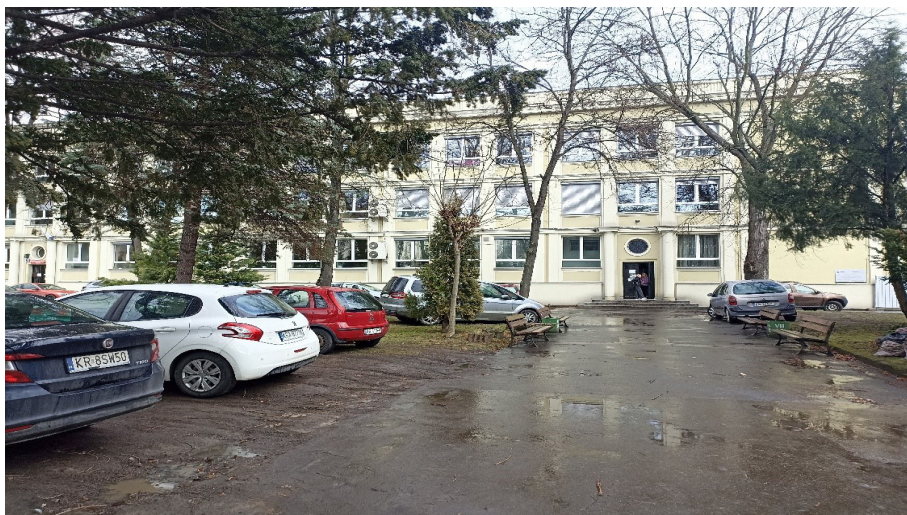
Il. 52. Elewacja frontowa liceum. Fot. D. Moskal.
