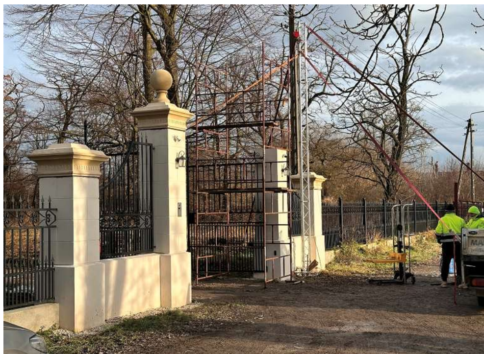
II. 5. Brama w trakcie budowy; 2024. Fot. aut.
