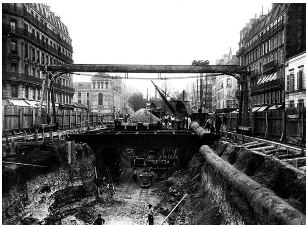
Il. 1. Prace przy paryskiej linii metra z końca XIX wieku, wykonywane w systemie otwartym kopania tuneli (Le piéton de Paris, b.r.)
