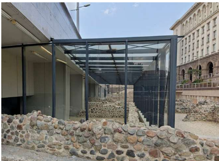
Il. 19. Sofia-Serdica II, widok na stację metra wraz z otoczeniem. Przykład zachowania szerokiego kontekstu historycznego, relikty z zewnątrz kontynuują się wewnątrz budynku stacji, 2024. Fot. aut.
