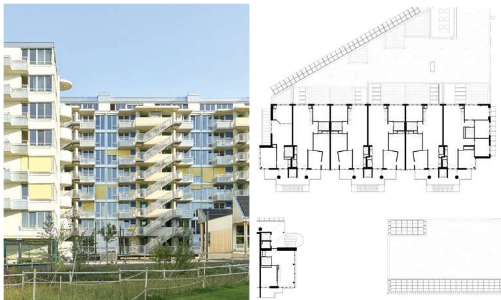
Il. 5. Zewnętrzne klatki schodowe w budynku mieszkalnym w Zurichu, DOSCRE (Knüsel, 2025)
