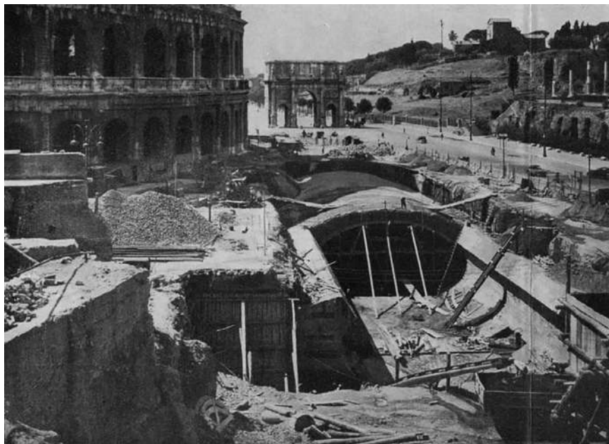
Il. 9. Budowa linii metra B w Rzymie, lata 1946–1955, widok na Koloseum i łuk Konstantyna Wielkiego (Ghella, b.r.)
