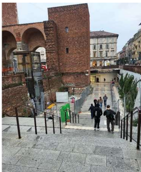
Il. 16. Część kompleksu bramnego (Pusterla) św. Ambrożego zbudowanego w XII wieku z wkomponowanym szybem windy, 2025. Fot. aut.
