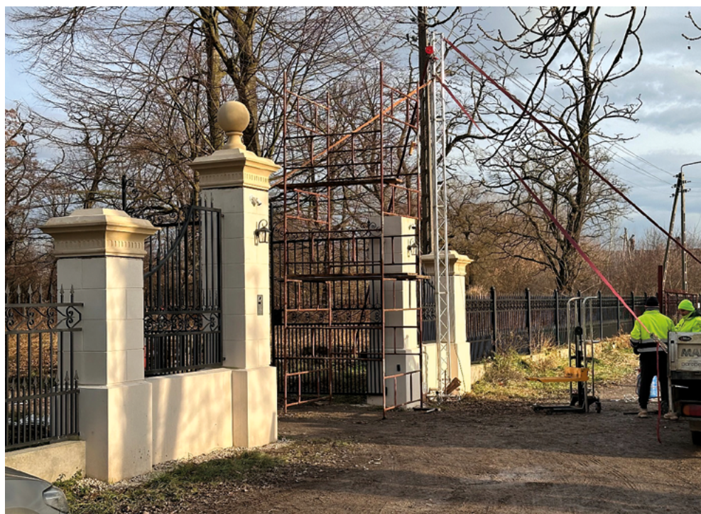
Il. 5. Brama w trakcie budowy; 2024. Fot. aut.
