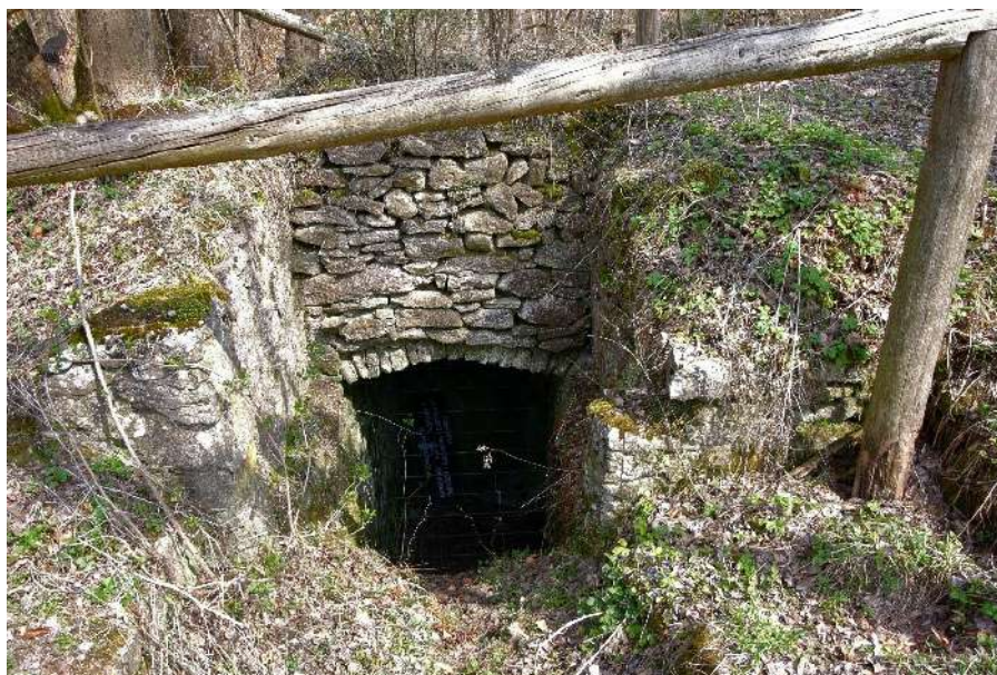
Il. 6. Klasztor Bazylianów w Monasterzu (przy wsi Werchrata, woj. podkarpackie) – murowane podpiwniczenia dawnego klasztoru, 2015. Fot. P. Sokalski
