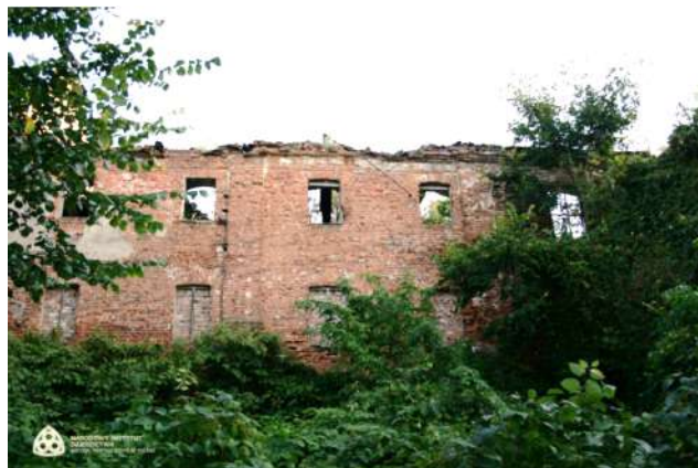
Il. 8. Klasztor Franciszkanów w Obornikach – elewacja południowa, 2010 (Łuczak, 2014)
