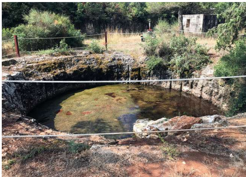
Il. 10. Bateria „Gomila” – pozostałości szybów fundamentowych haubic, obecnie wypełnione wodą opadową; w betonie są czytelne odciski śrub kotwiących. W tle budynek improwizowanej centrali artyleryjskiej i czołowa skalna ściana fosy; 2023. Fot. aut.
