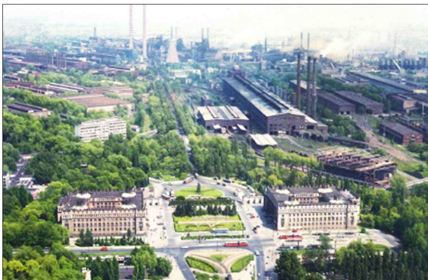
Ryc. 2. Droga nr 200 i oś kompozycyjna od bramy głównej do Siłowni i Wielkich Pieców na pocztówce z lat 90.
