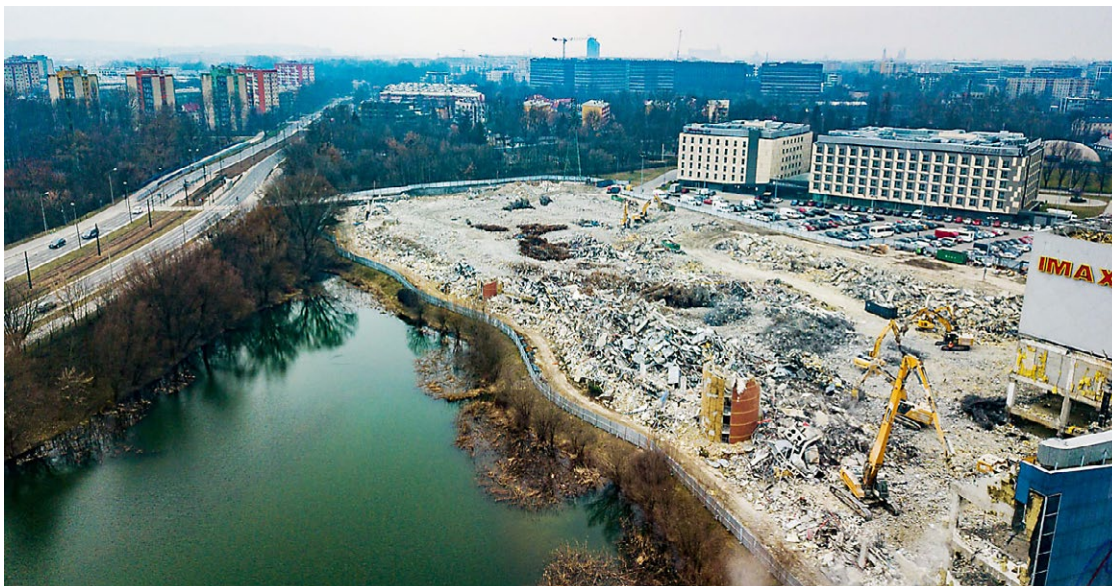
Ryc. 10. Panorama Dąbia – widoczny plac po rozbiórce galerii Plaza, fot. K. Kalinowski/LoveKraków.pl
