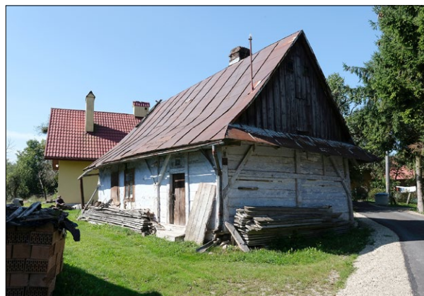
Ryc. 4. Pałaców, nr 27, widok ogólny; 2024, fot. A. Owerczuk Fig. 4. Pałaców, building numbered 27, general view; 2024, photo by A. Owerczuk
