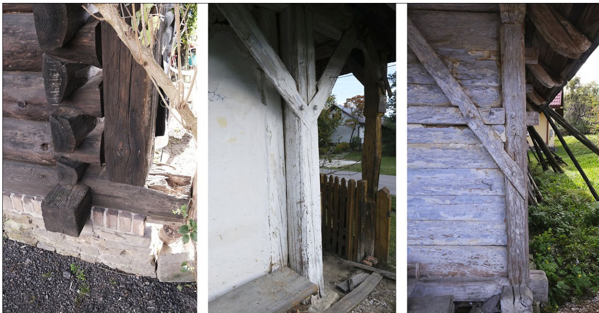
Ryc. 7. Rozwiązania konstrukcyjne: a) Pruchnik, Rynek nr 19, przysłup w połączeniu z konstrukcją zrębową, b) Kalwaria Pałacowska, nr 59, przysłup w połączeniu z konstrukcją sumikowo-łątkową, c) Pałac, nr 27, konstrukcja sumikowo-łątkowa z ryglem; wszystkie fot. A. Owerczuk, 2024
