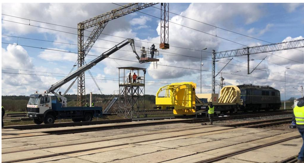
Rys. 2.1. Testowy pojazd najeżdżający (tzw. taran) z zamontowaną kabiną i absorberami bocznymi, zdjęcie wykonane podczas przygotowywania testu eksperymentalnego (zdj. A. Lisowska-Paluch)
