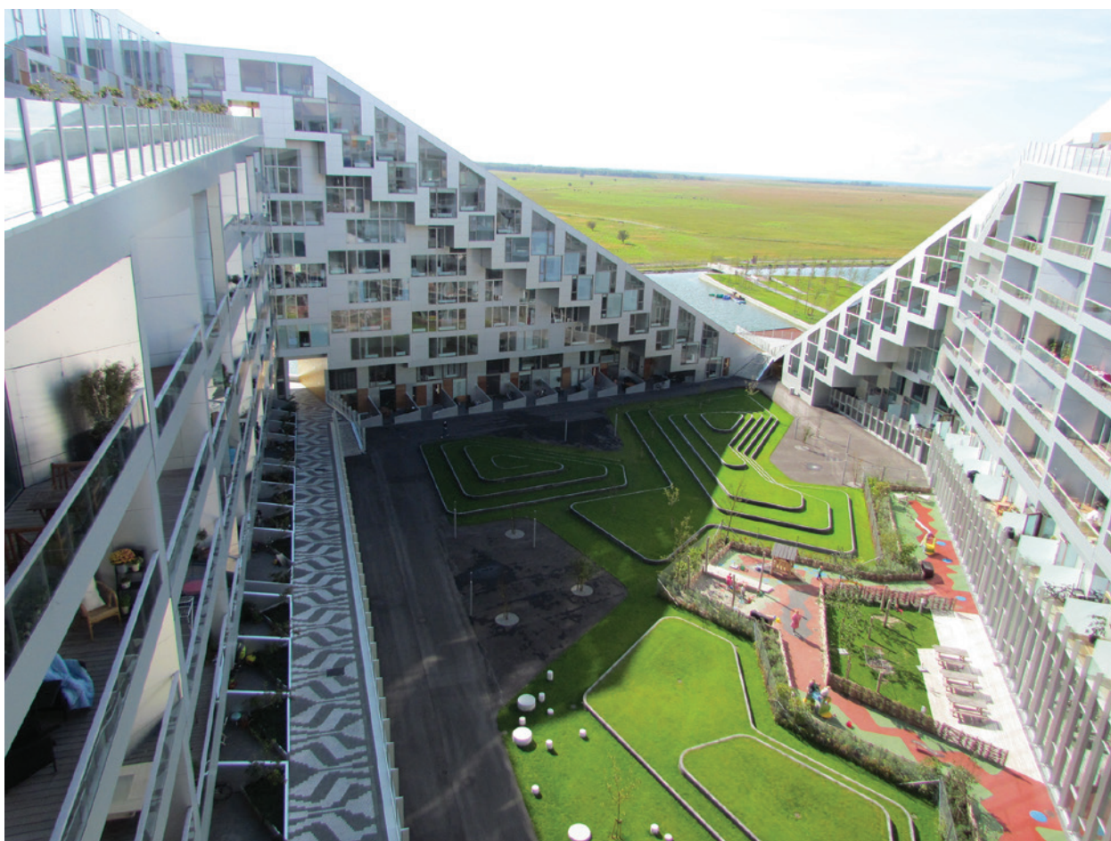
il. 6. Orestadt, Kopenhaga – osiedle intensywnej zabudowy mieszkaniowej oraz miejsc pracy, w otoczeniu otwartego krajobrazu i jednocześnie, w zasięgu dogodnych dojść pieszych do przystanku metra. Centrum Kopenhagi osiągalne jest metrem w ciągu kilkunastu minut. ARKKI ApS (master plan) 2011, (fot. K. Bieda) / Orestad, Copenhagen – a high density complex of homes and work places is surrounded by open landscape, but remains within convenient walking distance to metro station. A metro trip to Copenhagen city centre takes just over 10 minutes. ARKKI ApS (master plan) 2011
