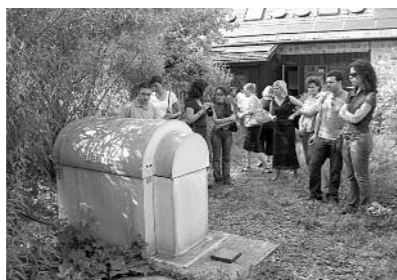
Oczyszczalnia w Stryszowie. Treatment plant in Stryszów.
