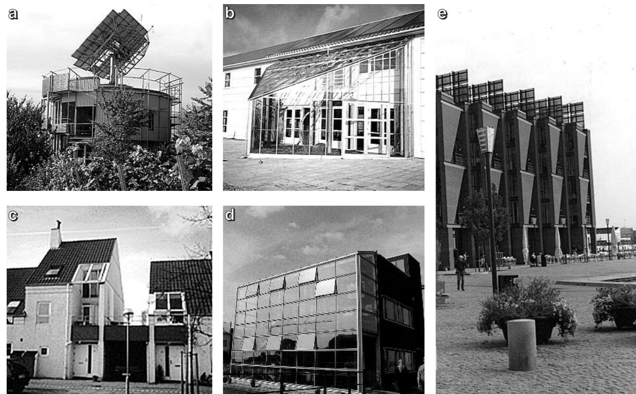
Ryc. 1. a – „Heliotrop” proj. R. Discha we Fryburgu, b, c – architektura eksponująca ogrody zimowe – osiedle Egebjerggård, Ballerup, Kopenhaga, Dania, d – pasywny dom słoneczny w zespole mieszkaniowym Bo01 „City of Tomorrow”, Malmö, e – architektura eksponująca systemy aktywne: kolektory słoneczne – zespół Bo01 Malmö, Szwecja. Fot. autorka. Ill. 1 a – “Heliotrope” designed by R. Disch in Friburg, b, c – architecture exposing winter gardens – estate Egebjerggård, Ballerup, Copenhagen, Denmark, d – passive solar house in residential complex Bo01 “City of Tomorrow”, Malmö, e – architecture
