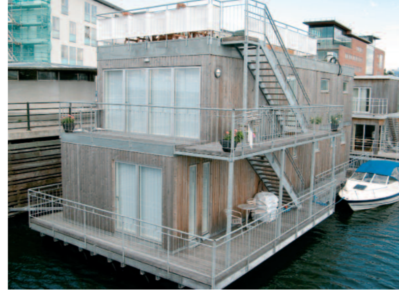
Pływające budynki w Malmö / Floating buildings in Malmö.
