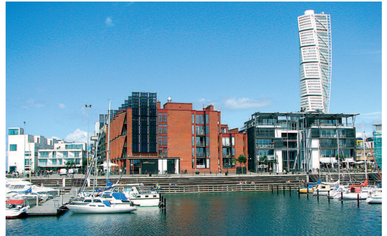
Il. 3. Ogniw fotowoltaiczne znajdujące się na jednym z budynków mieszkalnych w porcie jachtowym. Photovoltaic cells on one of the residential buildings in the marina.
