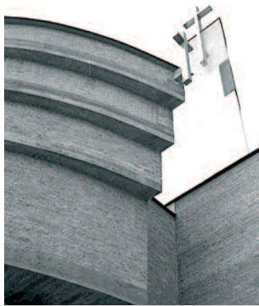
◄ Kościół p.w. Chrystusa Króla w Łękach Górnych – detale z realizacji. The Church of Christ the King in Łęki Górne: details of construction process.
