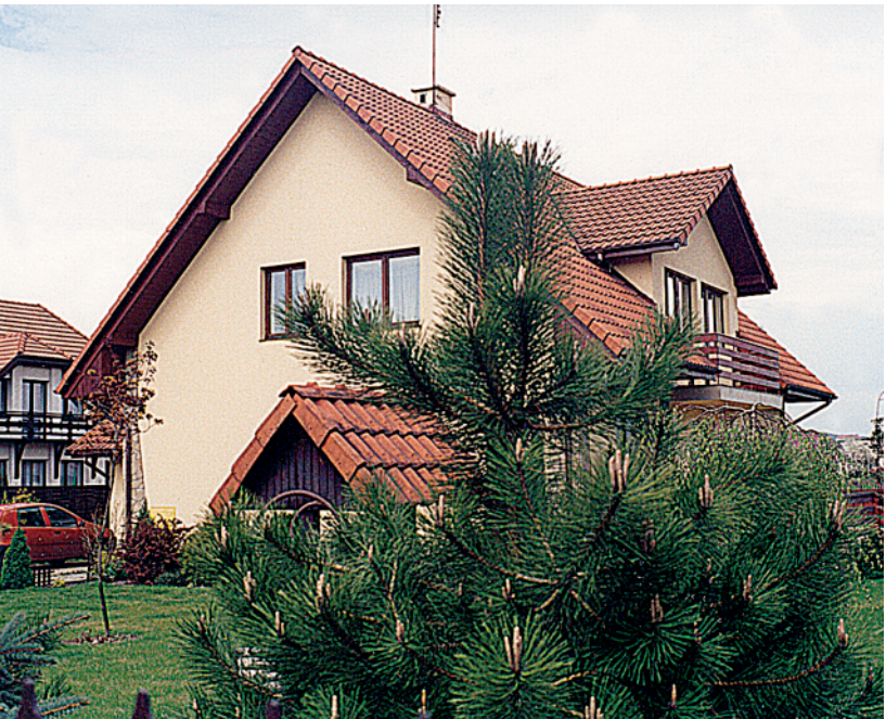
▲ Dom jednorodzinny JURA 8 w Krakowie - Kostrzu. Detached house JURA 8 in Cracow-Kostrze. (arch. arch. D. & M. Hyla).
