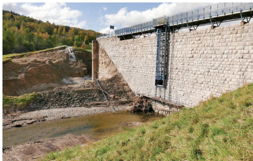
Przerwana zapora w Stroniu Śląskim Fot.: Krzysztof Radzicki
