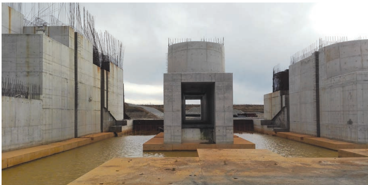
Budowa sekcji spustowo-przelewowej zbiornika „Racibórz” Fot.: Krzysztof Radzicki
