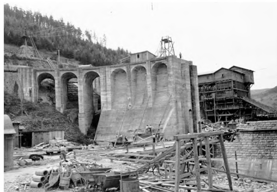
Budowa zapory „Porąbka” na Sole w latach 1921–1936 Fot.: NAC
