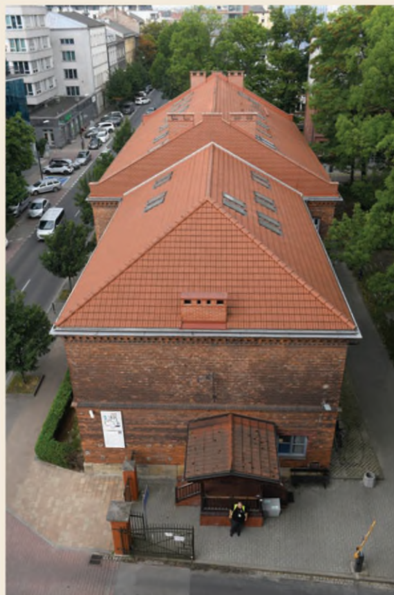
Po gruntownej modernizacji zabytkowego budynku Biblioteka PK zyska najwyższy standard jakości i dostępności
