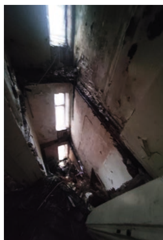
Il. 2. Różnica w stopniu zachowania elementów konstrukcji: stropów drewnianych oraz ścian ceramicznych w kamienicy przy ul. Górnośląskiej 22. Data wykonania zdjęcia: 02.2024. Źródło: Zdjęcie własne
