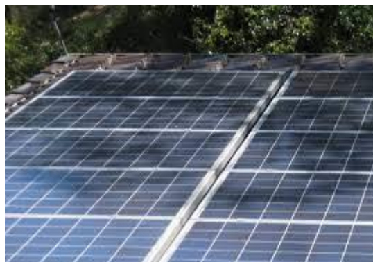
Fig. 18 Przykład złego umieszczenia fotowoltaiki [62]
