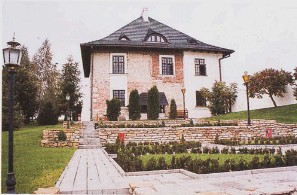
Założenie ogrodowe przy zabytkowym dworze obronnym w Jakubowicach Konińskich. Ogrody tarasowe – współczesna aranżacja ogrodowa (fot. arch. OOKK)
