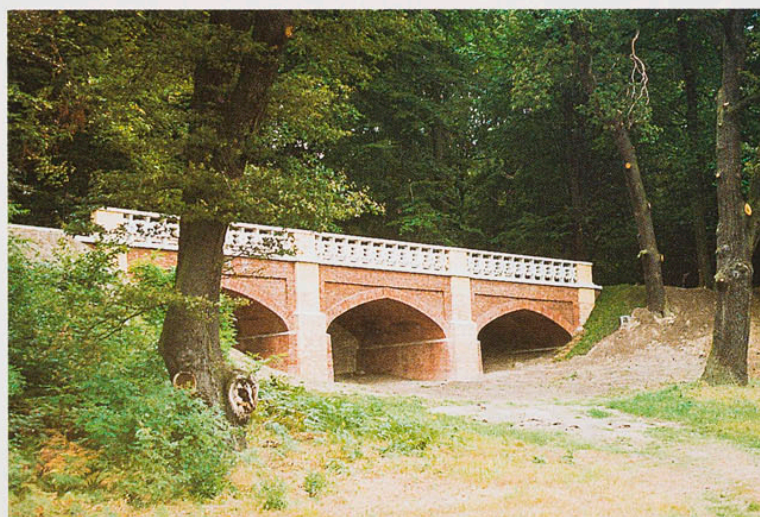
Park Mużakowski – Most Królewski po pracach konserwatorskich (fot. M. Rymkiewicz)
