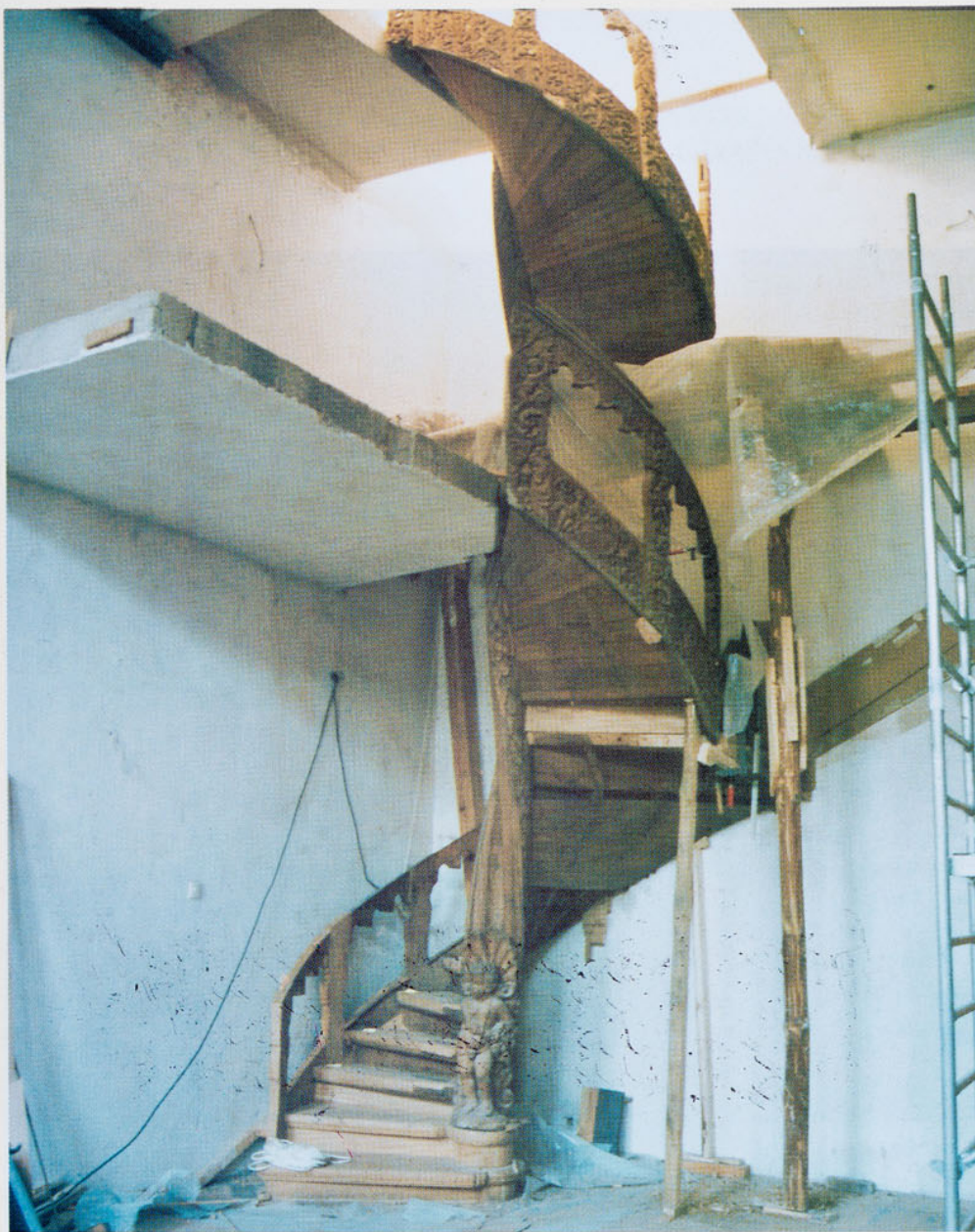
Sień Gdańska – początek montażu klatki schodowej.
