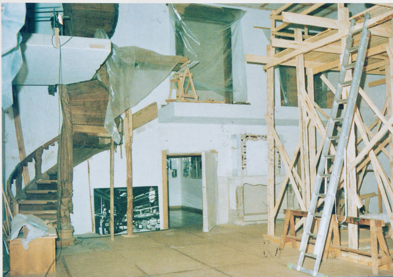
Sień Gdańska podczas prac budowlanych i konserwatorskich.
