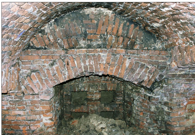
Ryc. 5. Dwupiętrowa nisza w podziemnym korytarzu, usytuowana bezpośrednio naprzeciw zawalonego odcinka; fot. R. Solecki
