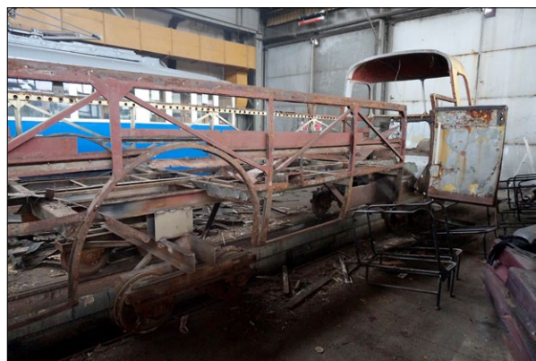
Ryc. 6. Silnie skorodowana kratownica nadwozia po demontażu poszycia; fot. K. Kołodziejczyk, 2021
