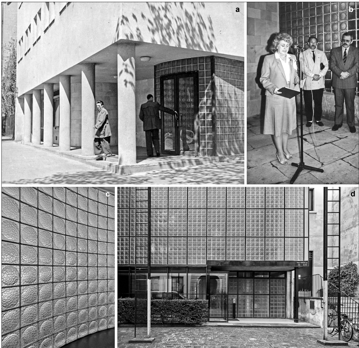
Ryc. 7. Zastosowanie luksferów w łódzkiej bibliotece w kontekście innych realizacji z tego okresu: a) podcień wejściowy i wiatrołap z luksferów z motywem koła w bibliotece publicznej w Łodzi ok. 1950 r., źródło: Polona.pl, sygn. F.25136/IIIA; b) uroczystość przywrócenia imienia Marszałka Józefa Piłsudskiego bibliotece publicznej w Łodzi w 1990 r., w tle wiatrołap z luksferów, źródło: Historia biblioteki [b.d.]; c) fragment ściany klatki schodowej z luksferami w budynku Starostwa Krajowego Pomorskiego i Komunalnej Kasy Oszczędności w Toruniu, proj. arch. Jerzego Wierzbickiego (1935–1936), fot. B. Homiński; d) elewacja budynku Maison de Verre w Paryżu, arch. Pierre Chareau i Bernard Bijvoët (1928–1932), fot. August Fischer, licencja CC BY-ND 2.0 https://creativecommons.org/licenses/by-nd/2.0/
