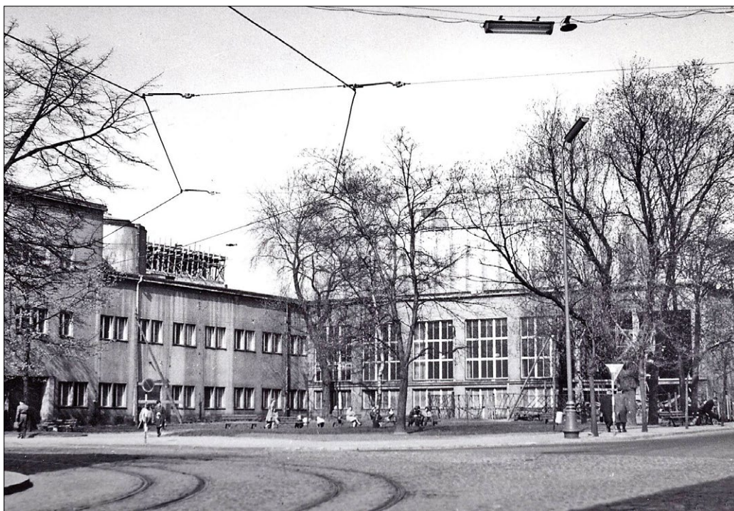
Ryc. 10. Biblioteka w trakcie rozbudowy w 1967 r., po prawej stronie widoczne dwa nowe przęsła czytelnii, jeszcze bez stolarki okiennej, w tle rusztowania przy budowie wolno stojącego magazynu książek w głębi działki; źródło: Historia biblioteki [b.d.]
