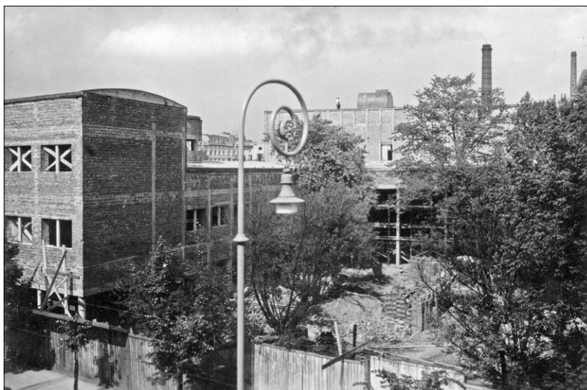
Ryc. 8. Biblioteka publiczna w Łodzi w trakcie budowy, przed wrześniem 1939 r.; źródło: Archiwum Państwowe w Łodzi, sygn. Ł-I 15/30 Fig. 8. Łódź public library under construction, before September 1939; source: Archiwum Państwowe w Łodzi, ref. no. Ł-I 15/30
