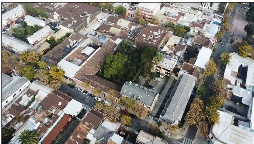
Ryc. 1. Dom Ignacego Domeyki, widok z lotu ptaka; Fundacja Pro Architectura, 2025
