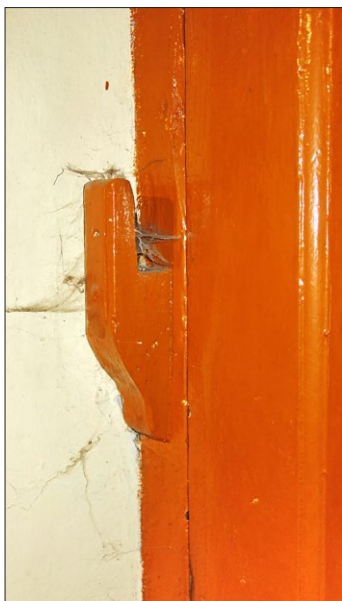
Ryc. 9. Detal do antywłamaniowego blokowania drzwi w Koszwałach
