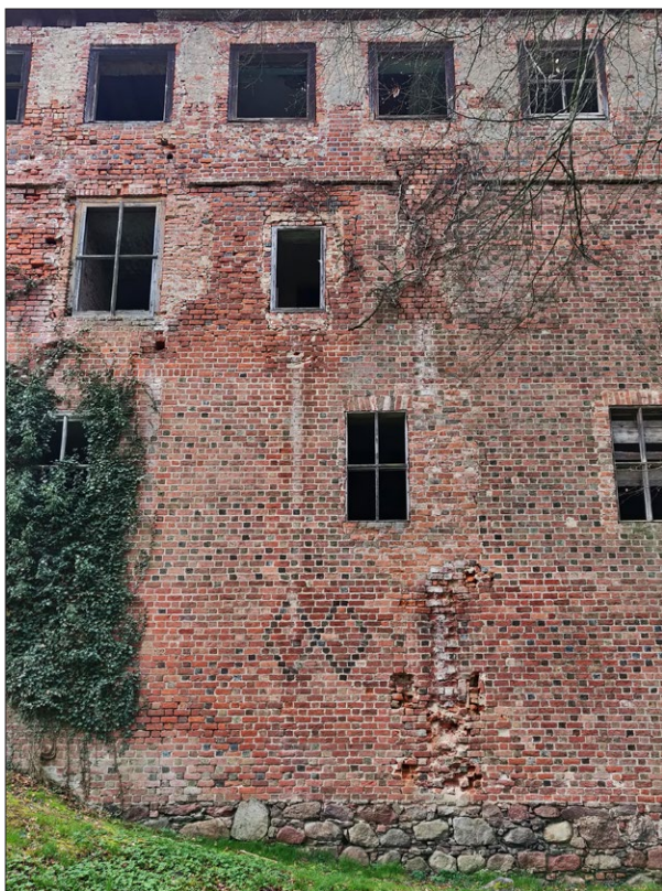
Ryc. 9. Północna część elewacji wschodniej z widocznym śladem latryny z III fazy oraz przebudowaniem pionu kominowego (?), 2024; fot. K. Wroński
