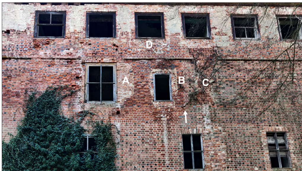
Ryc. 8. Górna partia północnej części elewacji z widocznym krenelażem; strzałką oznaczono linię strzępi między etapem IV i VI fazy I, A, B – domniemane ościeża okien z fazy III, C – przemurowanie pionu kominowego, D – domniemane miejsce żurawia z fazy IV, 2024; fot. K. Wroński
