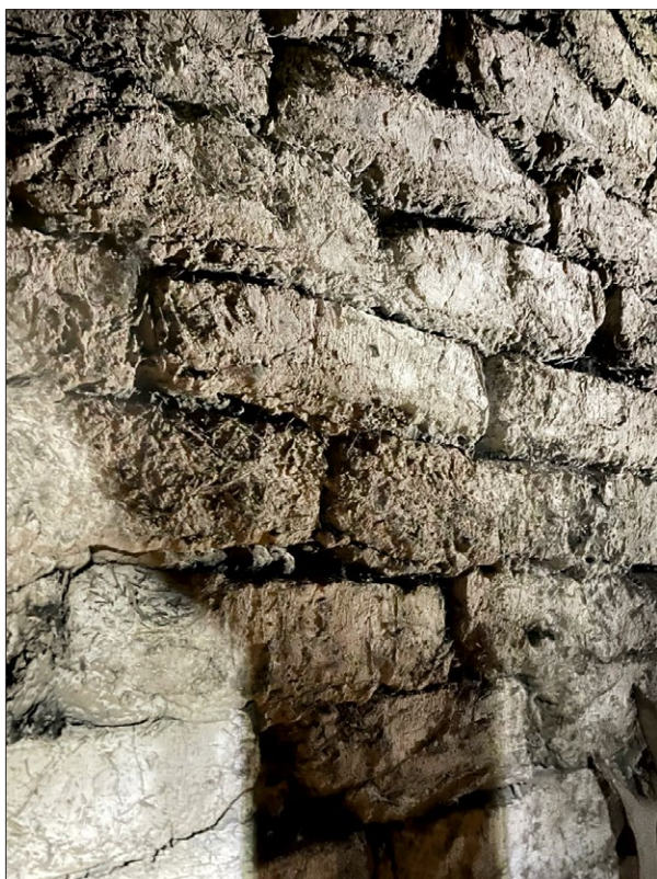
Ryc. 8. Widoczna na poddaszu cegła adobe; Fundacja Pro Architectura, 2025
