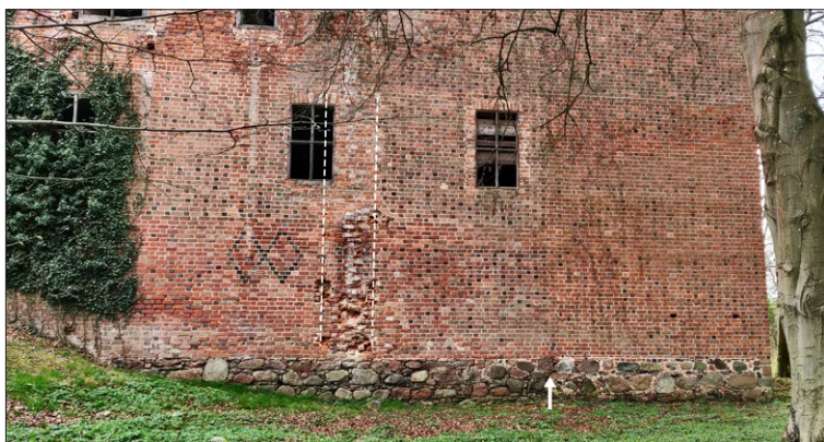
Ryc. 5. Północna część elewacji wschodniej; strzałką oznaczono linię strzępi między I a II etapem fazy I, linie przerywane wyznaczają obrys latryny z fazy III, 2024; fot. K. Wroński
