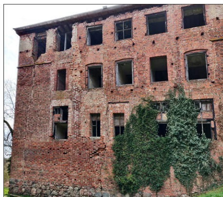
Ryc. 6. Południowa część elewacji wschodniej, 2024; fot. K. Wroński
