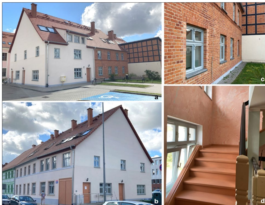
Ryc. 10. Kamienica po rewaloryzacji, 2025: a) widok od strony podwórza, b) widok z ul. Ratuszowej od północy, c) fragment elewacji ceglanej od strony podwórza z wymienioną stolarką okienną, d) sień z wewnętrzną klatką schodową
