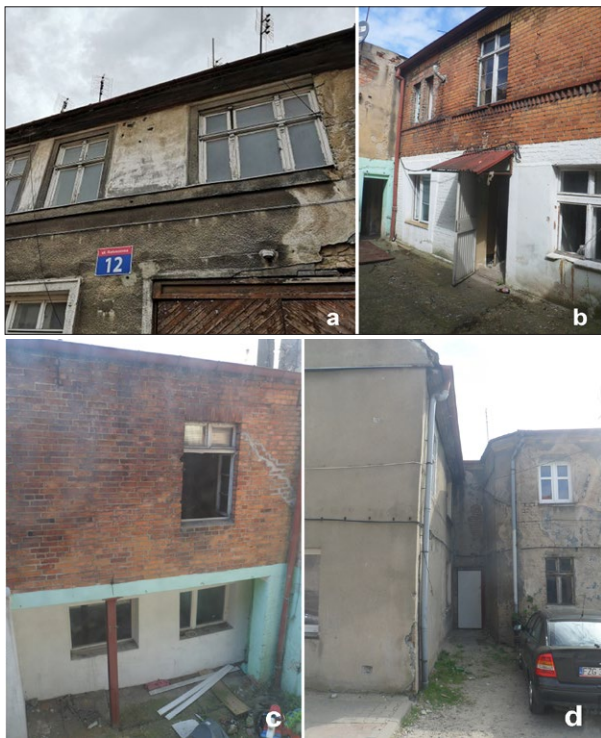
Ryc. 3. Stan zachowania elewacji budynku w 2017 r.: a) fragment elewacji od strony ul. Ratuszowej, b) fragment elewacji od strony dziedzińca, c) fragment elewacji oficyny tylnej od strony dziedzińca, d) wejście główne do kamienicy przy oficynie bocznej
