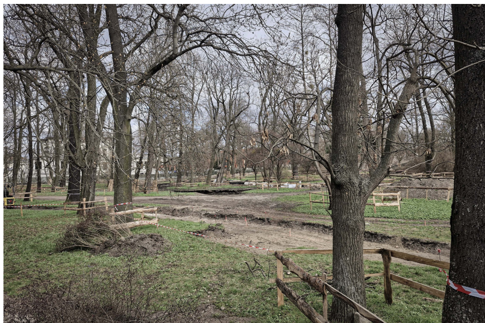
Il. 4. Odtwarzanie koryta rzeki Lamus – wykopy pod nowy odcinek powierzchniowy w parku przy ul. Kilińskiego, 2026. Fot. G. Bajas
