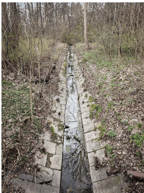
Il. 3. Odkryte koryto rzeki Bałutki przy ul. Biegunowej, 2026. Fot. G. Bajas
