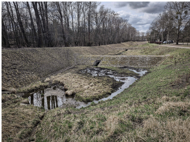
Il. 5. Zróżnicowany stopień przekształcenia koryta rzeki Sokołówki przy ul. Fiołkowej, 2026. Fot. G. Bajas
