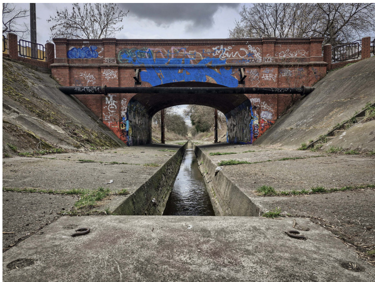
Il. 2. Zabetonowane koryto rzeki Jasień w rejonie ul. Cieszkowskiego – przykład silnej technicznej ingerencji w naturalną strukturę cieku, 2026. Fot. G. Bajas
