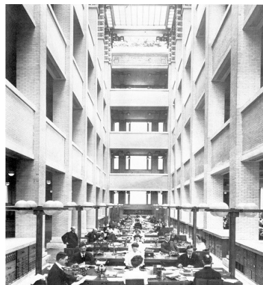
Il. 6. Wnętrze biurowca Larkin w Buffalo, centralna przestrzeń biurowa, USA 1906; architekt: Frank Lloyd Wright (INSinsideIDE, 2018a)
