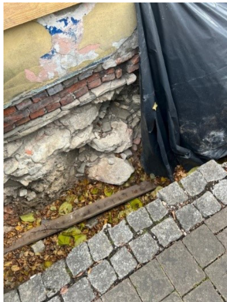
Il. 7. Fragment odsłoniętej ściany przeznaczonej do naprawy, 2025. Fot. aut.
