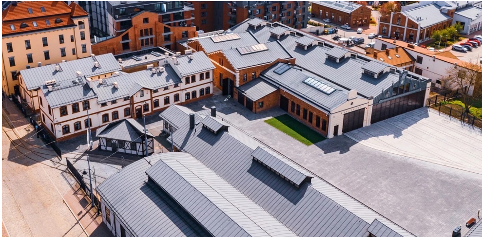
Fig. 4. The tram depot today (Muzeum Inżynierii i Techniki, 2021c)
