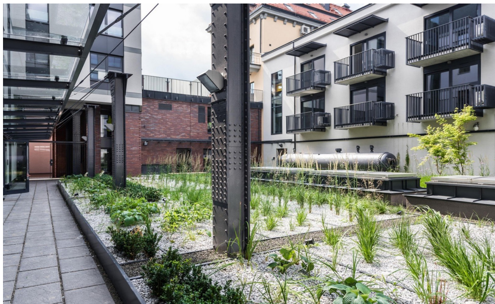
II. 7. Ul. św. Wawrzyńca 21. Zostawione relikty dawnego przeznaczenia – stalowa konstrukcja nośna wykorzystana jako podpora szklanego zadaszenia (Hamilton May, 2017)
