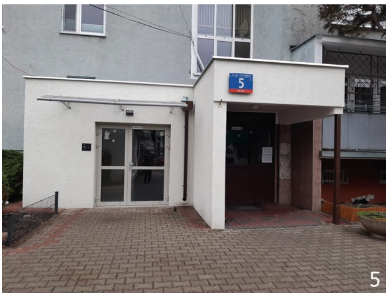
III. 5. Odrębne wejście do pomieszczenia z windą w miejscu dawnego zsypu. Zdjęcie A. Orchowska
