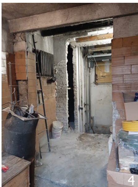
II. 4. Prace remontowe – dostosowanie zsypu do windy, umożliwienie mieszkańcom dostępu do komunikacji pionowej z poziomu gruntu. Stan podczas remontu i obecnie. Zdjęcie A. Orchowska
