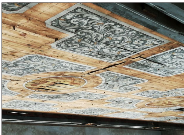
Ryc. 6. Prace budowlano-renowacyjne (2019–2021) we wnętrzu kościoła, z uwzględnieniem prac stolarskich na stropie; fot. A. Sikorski
