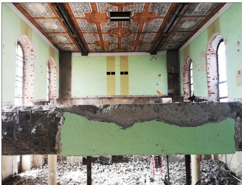
Ryc. 5. Prace budowlano-renowacyjne (2019–2021) we wnętrzu kościoła, z uwzględnieniem prac stolarskich na stropie; fot. A. Sikorski Fig. 5. Construction and renovation works (2019–2021) in the interior of the church, including carpentry works on the ceiling; photo: A. Sikorski
