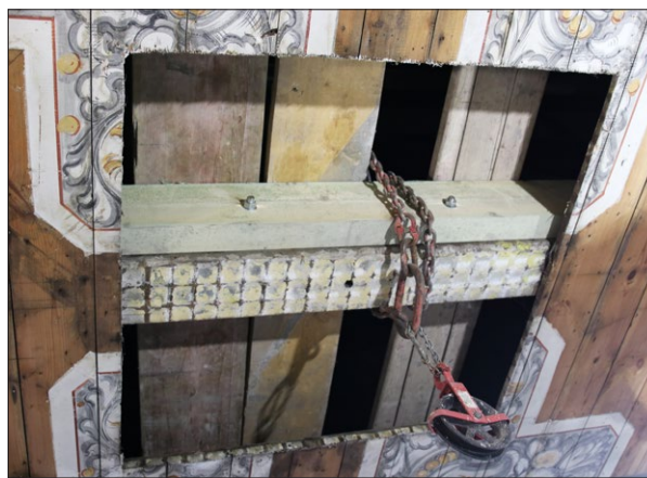
Ryc. 7. Prace stolarsko-renowacyjne przy uzupełnianiu desekowania we wtórnie wyciętych otworach wentylacyjnych na stropie, 2018; fot. A. Kuszlis-Grygolicz
