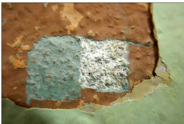
Ryc. 4. Fakturalny, gruzelkowy tynk w podłożu warstw malarskich, tj. pobiałej i monochromii błękitnoszarej na południowej ścianie nawy dawnego kościoła; widoczne także liczne wtórne warstwy malarskie odspajające się od pierwotnej monochromii, 2018; fot. M. Rudy
