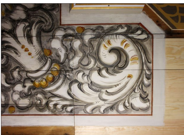
Ryc. 8. Po pracach stolarskich wykonano zabiegi konserwatorskie i rekonstrukcje malarskie, których zarys kompozycyjny przenoszono za pomocą szablonu, 2018; fot. A. Kuszlis-Grygolicz
