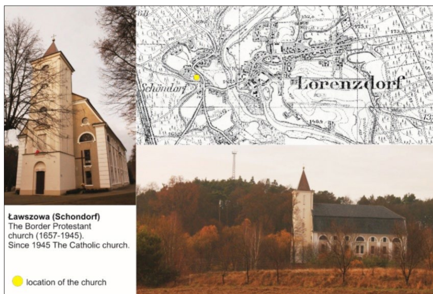
Ryc. 3. Ławszowa, kościół graniczny – przykład lokalizacji na lewobrzeżnej 12-metrowej terasie nadzalewowej Kwisy, 2022; fot. J. Łach Fig. 3. Ławszowa, border church – an example of a location on the 12-m-high left-bank terrace above the floodplain of the Kwis River, 2022; photo by J. Łach
