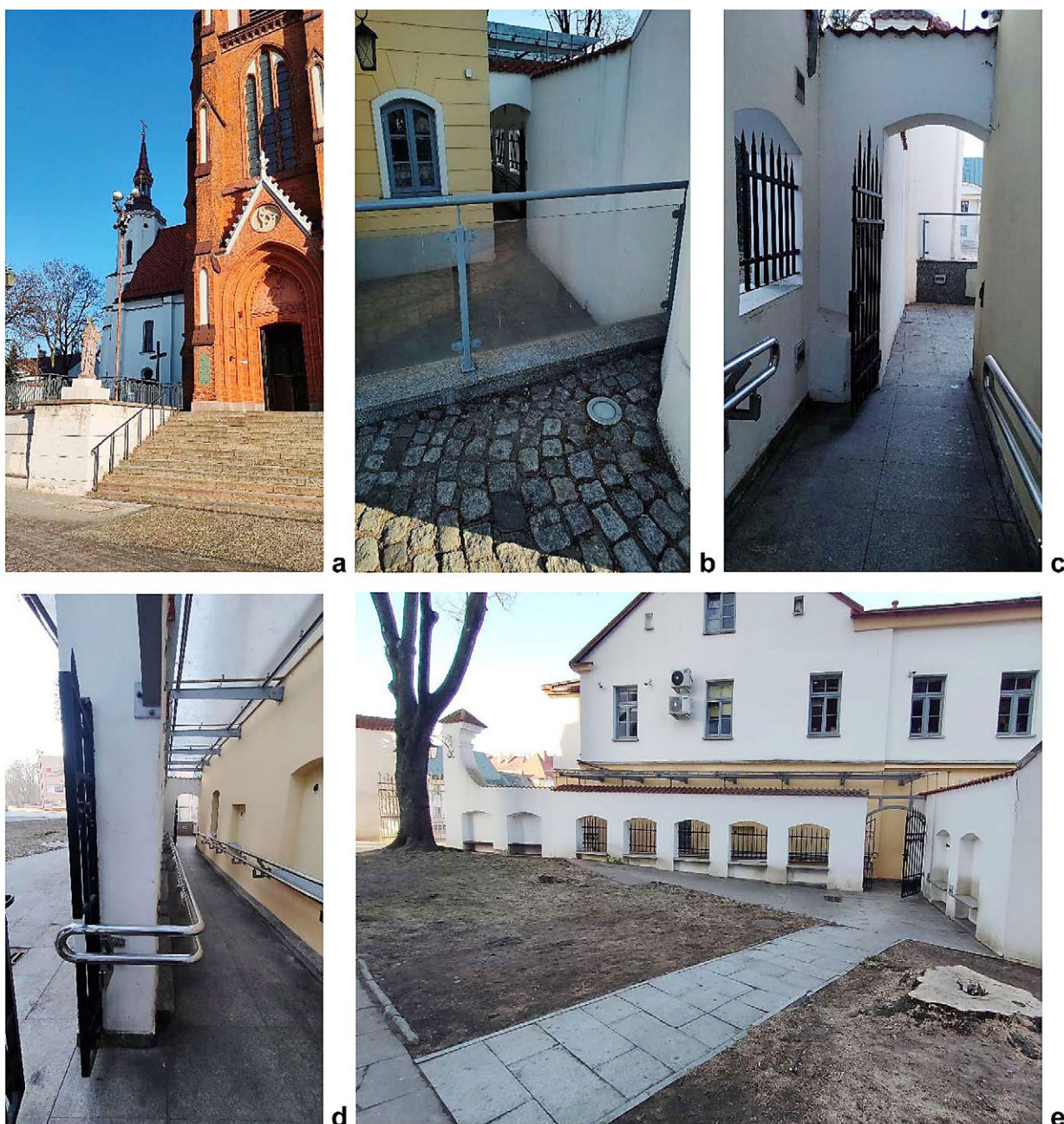
Ryc. 4. Kościół farny w Białymstoku: a) wyniesione wejście główne ze schodami, b) ukryty początek pochylni, c–d) pochylnia poprowadzona między zabytkowym ogrodzeniem a zabudową towarzyszącą, e) fragment trasy alternatywnej; fot. M. Magdziak, 2026
