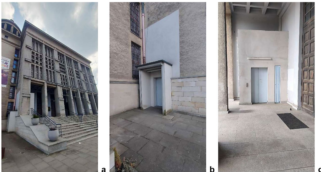
Ryc. 2. Kościół św. Teresy w Łodzi: a) główne schody wejściowe i lokalizacja windy, b) winda usytuowana przy schodach, c) strefa wejściowa z dalszymi barierami; fot. M. Magdziak, 2026
