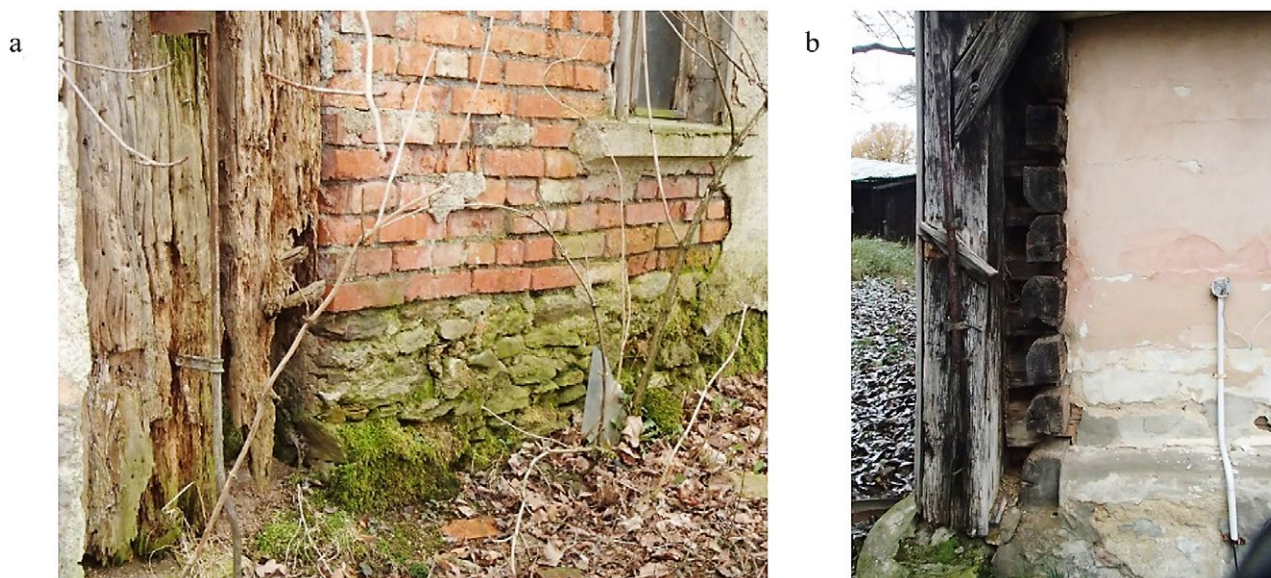
Ryc. 4. Przykład: a) obmurowania, b) otynkowania izby zrębowej; autorem wszystkich zdjęć jest K. Ałykow Fig. 4. Example: a) brickwork, b) plastering of log cabins; all photos by K. Ałykow
