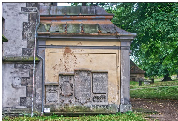
Fig. 5. East facade, previous condition, 2021 Ryc. 5. Elewacja wschodnia, stan przed renowacją, 2021
