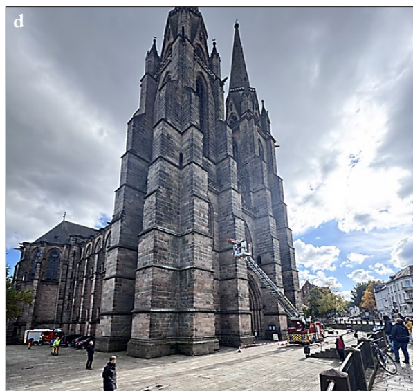
Ryc. 4. Kościół św. Elżbiety w Marburgu (Niemcy): a) trasa turystyczna na poziomie pierwszej kondygnacji prowadząca do klatki schodowej, b) trasa turystyczna ponad sklepieniami kościoła, c–d) akcja ratownicza straży pożarnej i służb medycznych; fot. P. Opałka, 2025
