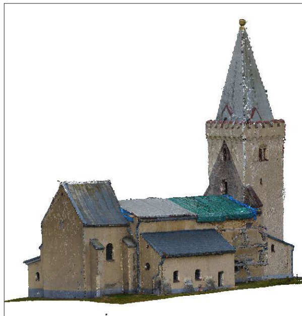
Ryc. 2. Chmura punktów ze skaningu laserowego (uzupełniona fotogrametrią), oprac. własne
