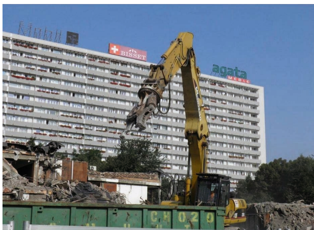
II. 5. Wyburzanie Pałacu Ślubów, 2011. Źródło: Śląskie naszemiasto, fot. Adrian Leks (dostęp: 19.11.2025)
