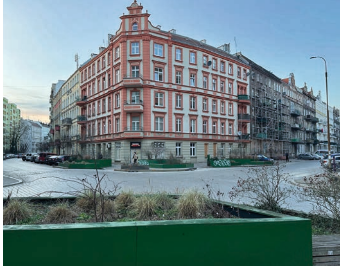
II. 9. Widok na parklety na skrzyżowaniu ul. Daszyńskiego i Żeromskiego we Wrocławiu. Źródło: autor
