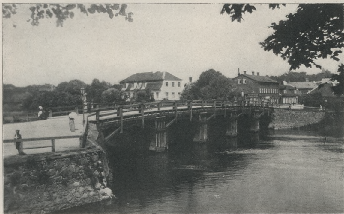
Dorpat: Holzene Brücke über den Embach
