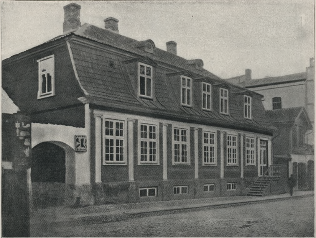
Wenden in Livland: Das Haus Heinrich von Meyer, erbaut etwa 1800, ein dunkler, unbekleideter Holzbau mit weißen Säulen, Sims und Fenstern
