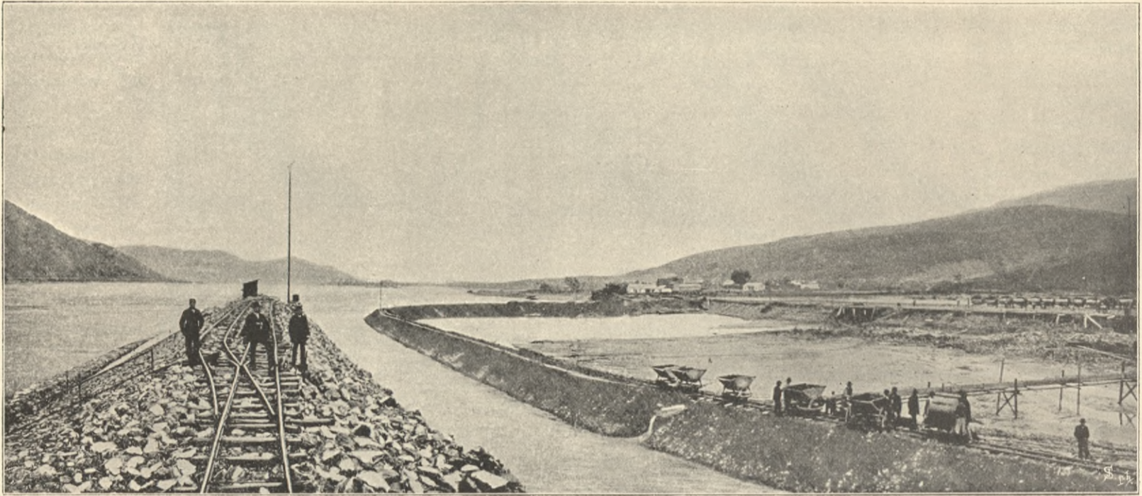
ENDE DES CANALS BEIM EISERNEN THOR (1894).
