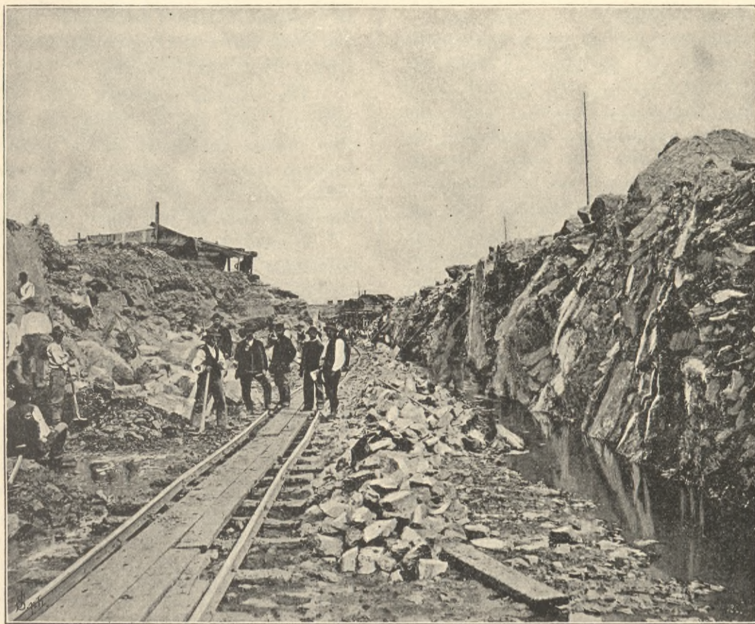
SPRENGUNG DES CANALS BEIM EISERNEN THOR (PLOCSIABANK) (1893).
