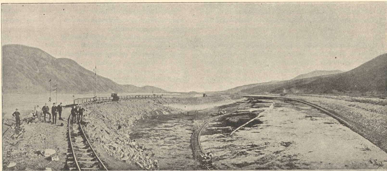
CANAL BEIM EISERNEN THOR NACH BEENDIGUNG DER SPRENGARBEITEN.
