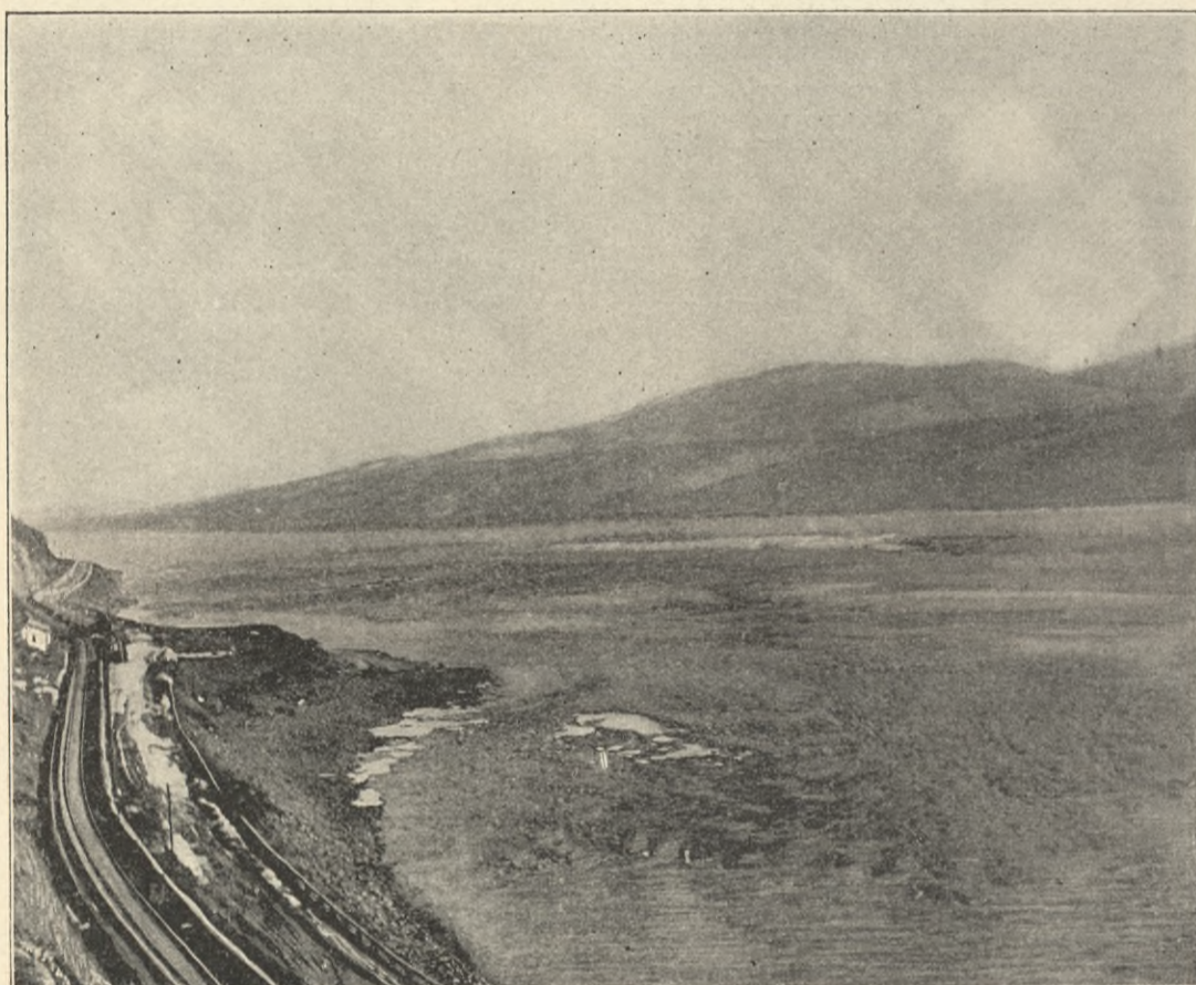
DAS EISERNE THOR VOM LINKEN UFER AUS.
