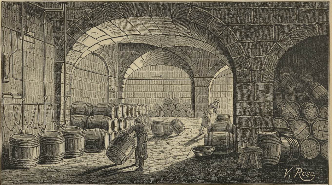
Ansicht einer Kellerei mit Druckluft-Einrichtung.
