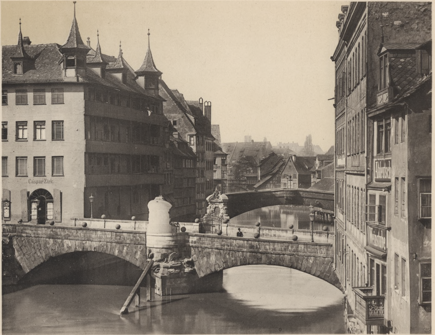
Abb. 36. Museumsbrücke und Fleischbrücke.
