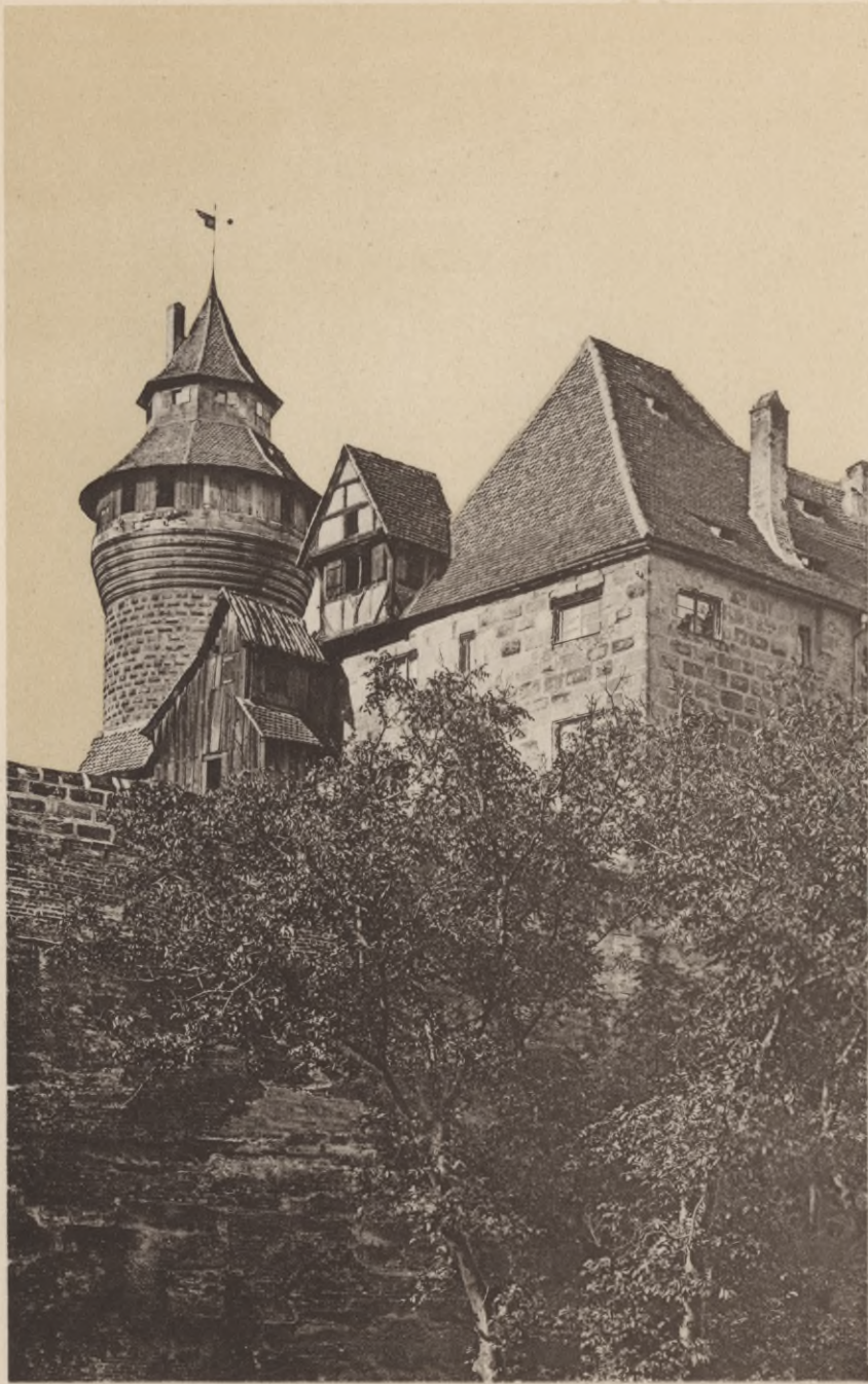
Abb. 5. Burg. Amtmannswohnung und Sinwellturm.
