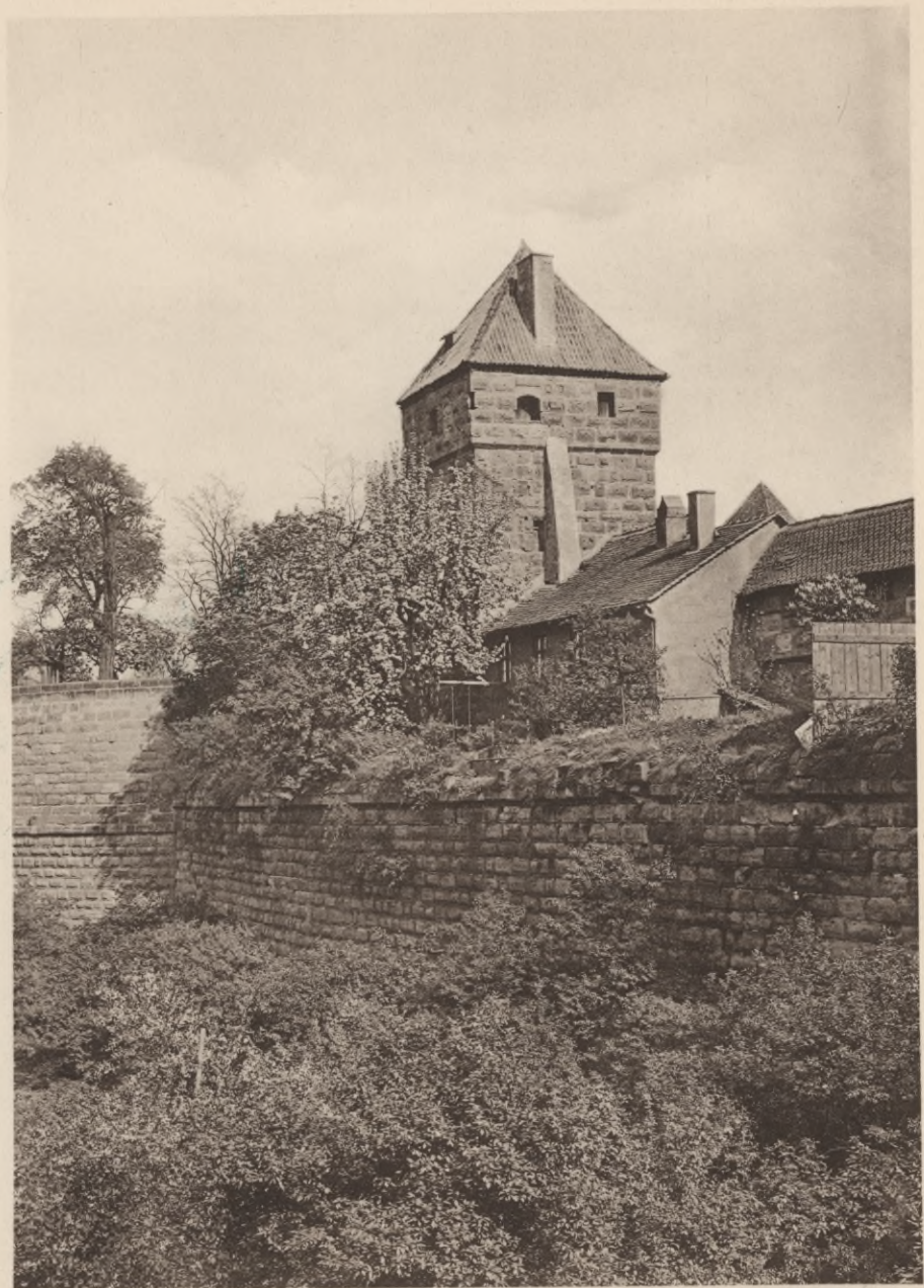
Abb. 19. Mauerpartie am Maxtorgraben.
