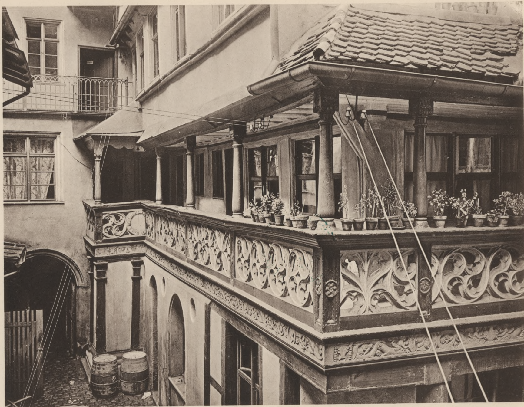
Abb. 75. Partie aus dem Hof Tucherstrasse 15. 1543.
