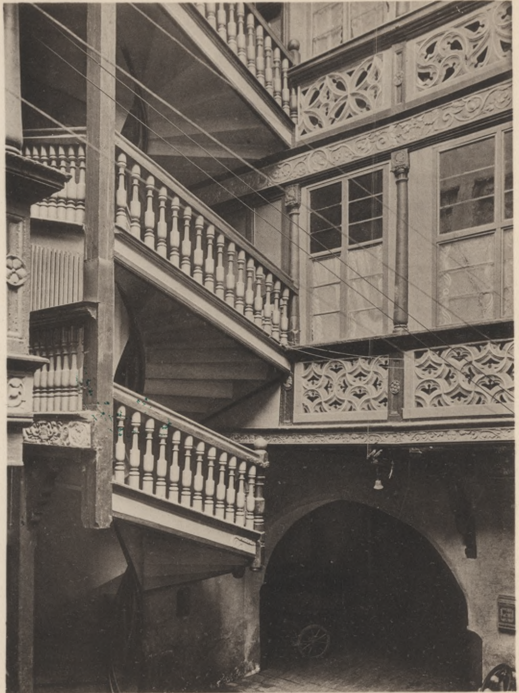
Abb. 74. Treppenanlage im Hof Tucherstrasse 15. 1543.
