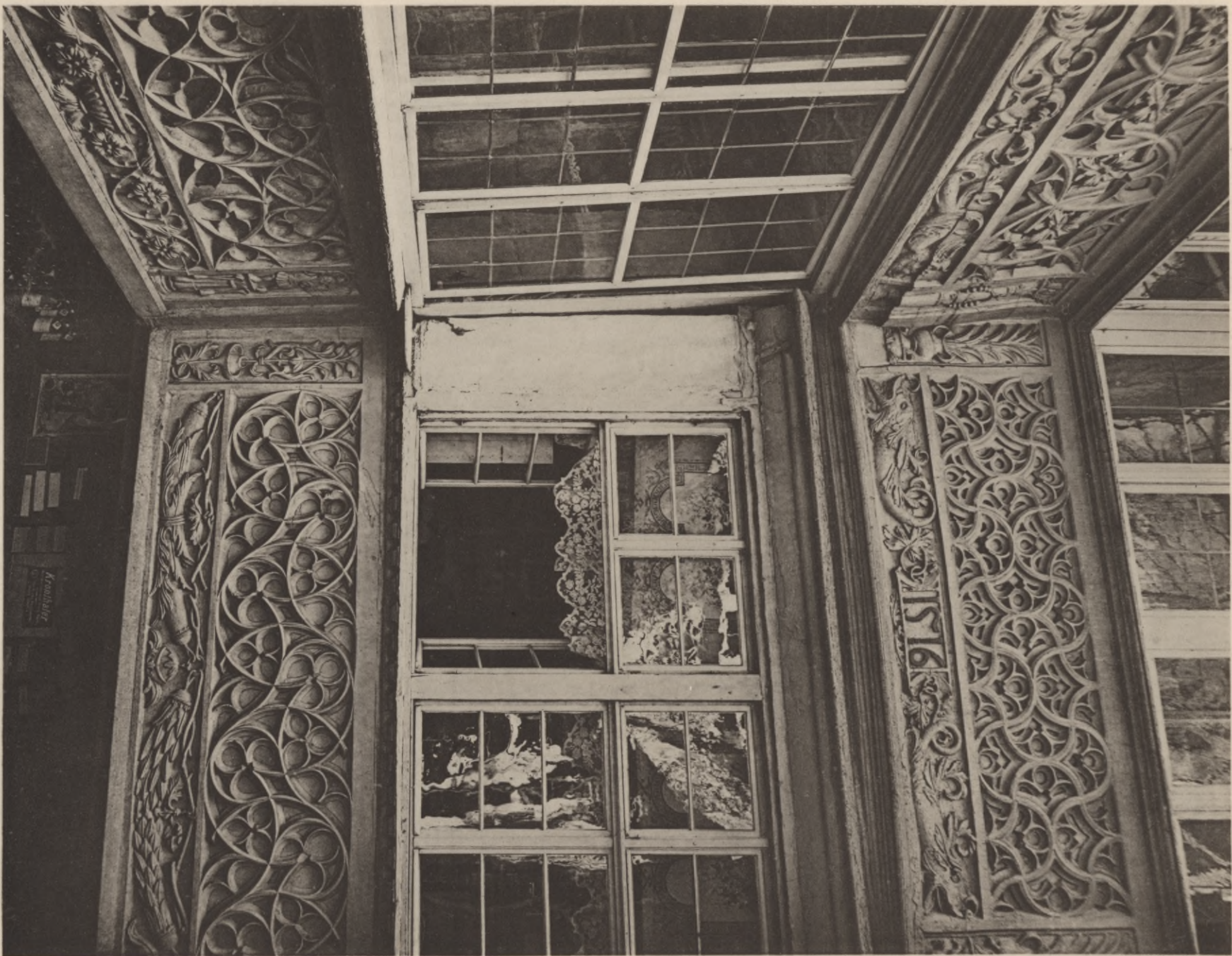
Abb. 65. Partie aus dem Hof Winklerstrasse 1. 1516.
