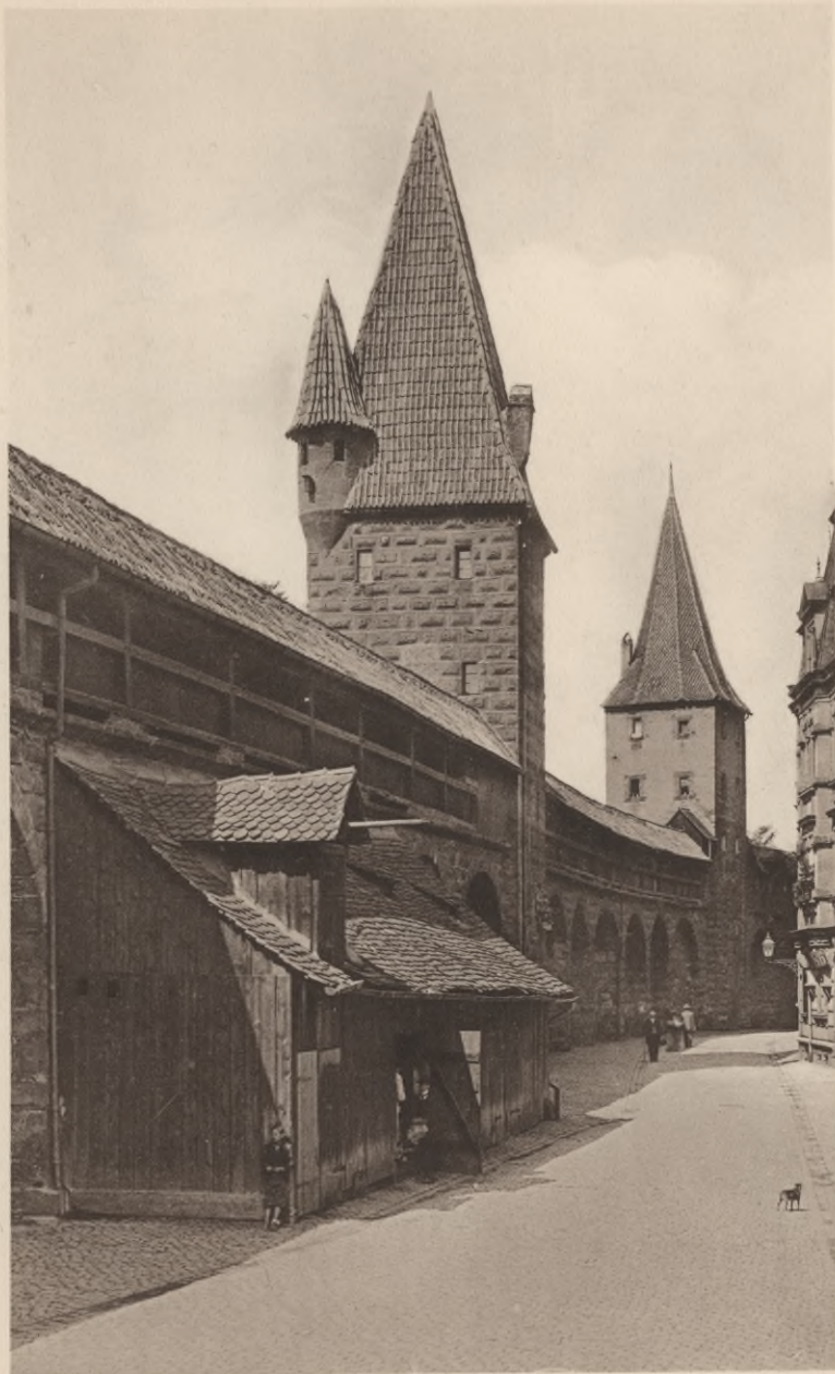
Abb. 18. Innere Mauer an der Engelhardsgasse.
