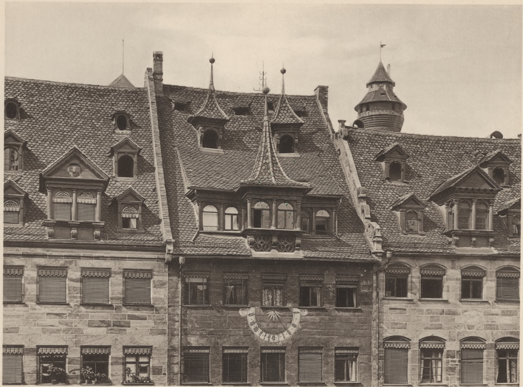
Abb. 104. Dachpartie am Albrecht Dürerplatz. Anf. 17. Jahrh.
