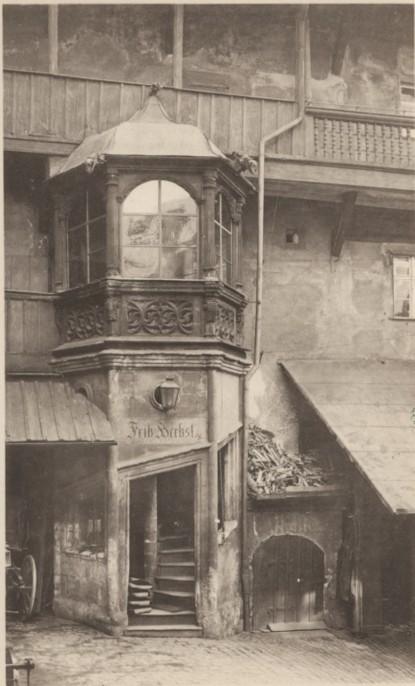
Abb. 90. Treppentürmchen im sogenannten Kutschershof, Brunnengasse 14 und 16. Um 1600.
