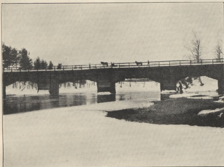
Fig. 20. Landsvägsbro öfver Kiimasjoki 31/m 1911.
