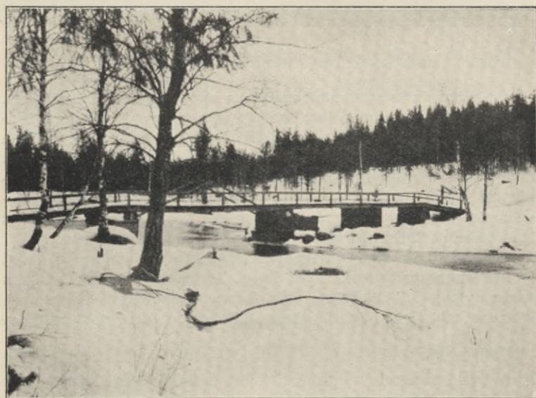
Fig. 18. Landsvägsbro öfver Kiimasjoki 31/III 1911.
