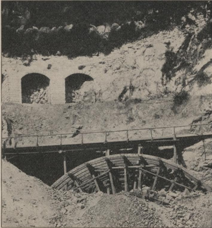
Abb. 52. Das Lehrgerüst der Rappenschluchtbrücke.
