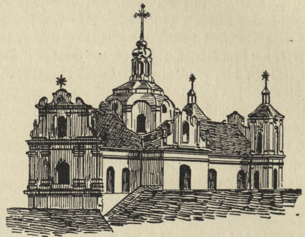
Wilna, Nikolaikirche. Ansicht von der Chorseite.
